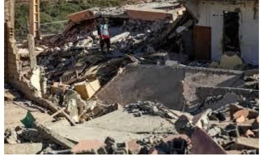
صورة لبعض المباني المتأثرة
